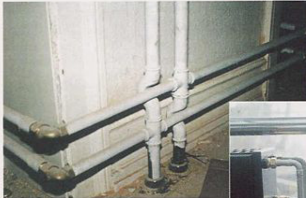
Foto fra renoveringsbyggeri i København.
